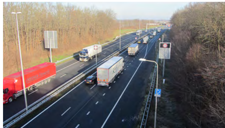
Verdiepte ligging A2 Richting Noorden vanaf KW Postweg
